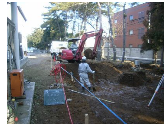
図-3 汚染土の掘削除去
