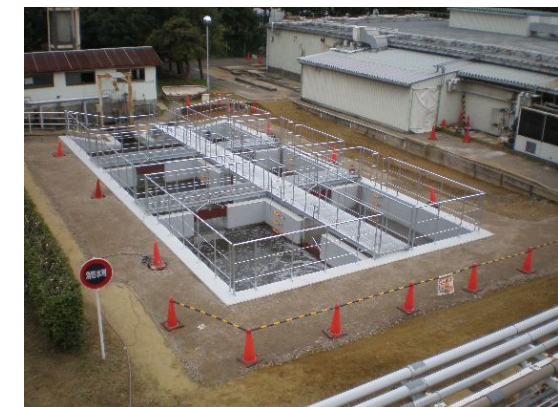
図-4 工場排水放流槽の設置
